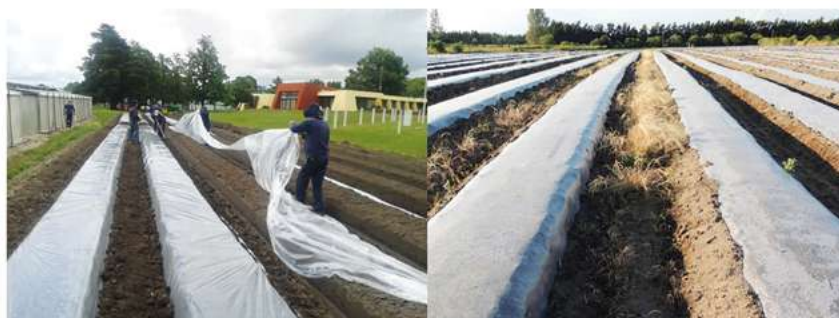
FIGURA 2. COLOCACIÓN DEL POLIETILENO EN LOS CANTEROS A SOLARIZAR
