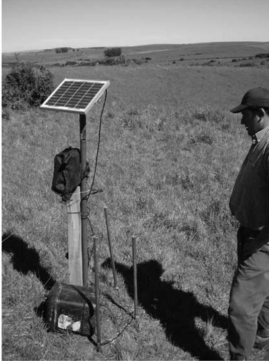
Detalle constructivo de la estación donde se ubica el panel solar, el electrificador, la batería y tres jabalinas (implementado por Alcides)
