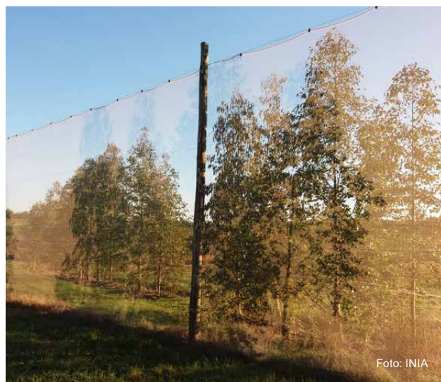
Figura 4 - Malla perimetral para aislar cuadros de producción, San Miguel Global S.A.
