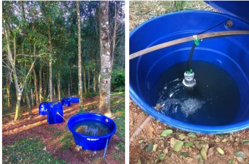
FIGURA 1. Sistema de filtração lenta completo. A – sistema completo. B – Detalhe do recipiente de armazenamento final. Campo Largo – Paraná – Brasil.
