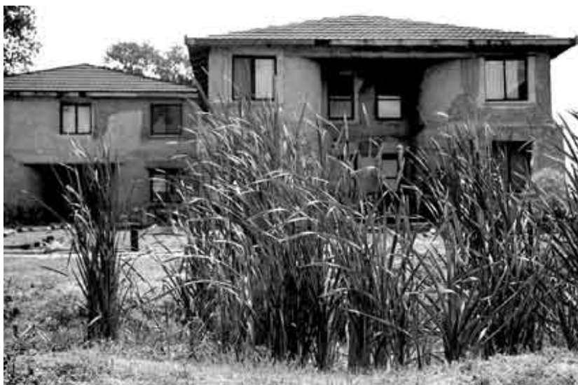
Sistema de saneamiento con plantas de totora en la cooperativa Guyunusa, en Solymar Norte, departamento de Canelones. * FOTO: PABLO NOGUEIRA
